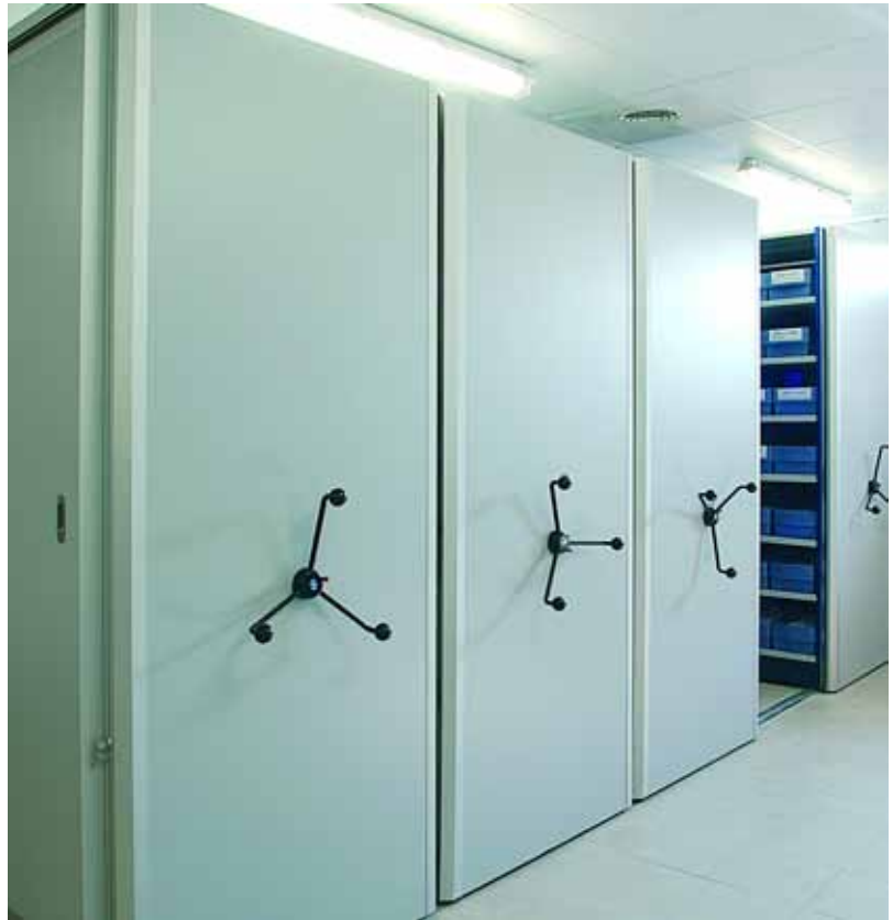
Almacén de piezas de recambio.
